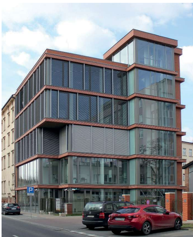
Rys. 1. Budynek Małopolskiego Laboratorium Budownictwa Energooszczędnego Politechniki Krakowskiej
