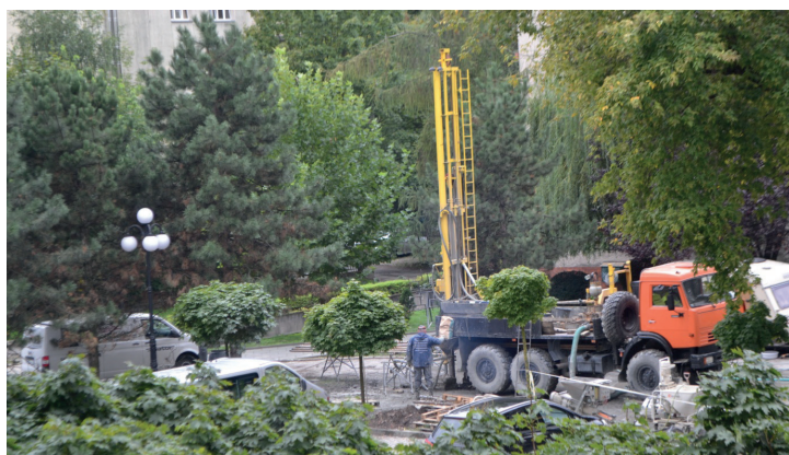
Rys. 9. Wiertnica podczas wiercenia otworów na polu B Laboratorium Geoenergetyki w Krakowie (fot. Tomasz Śliwa)
