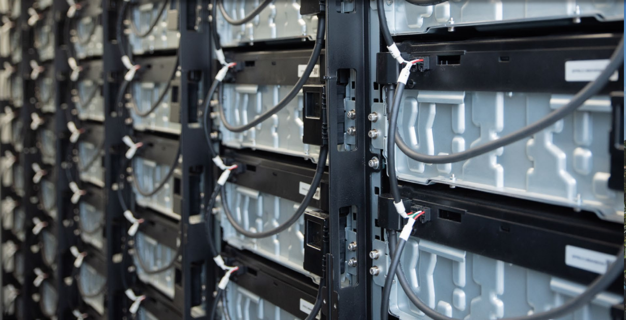
Podłączenie magazynu energii o pojemności 837 kWh
