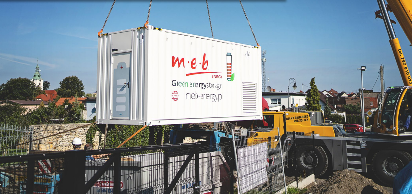
Podłączenie magazynu energii o pojemności 837 kWh
