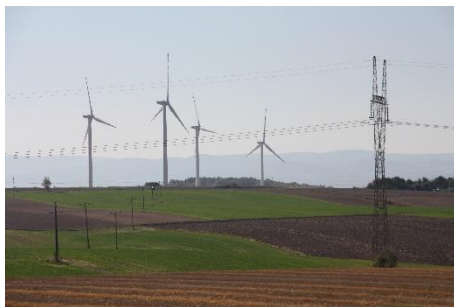
FW LIPNIKI 30,75 MW przyłączona do SE Cieszanowice
