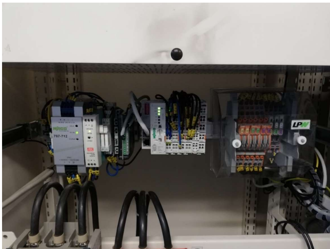
Rys. 5.6 Smart PG zainstalowany w rozdzielni MOCAR 58
