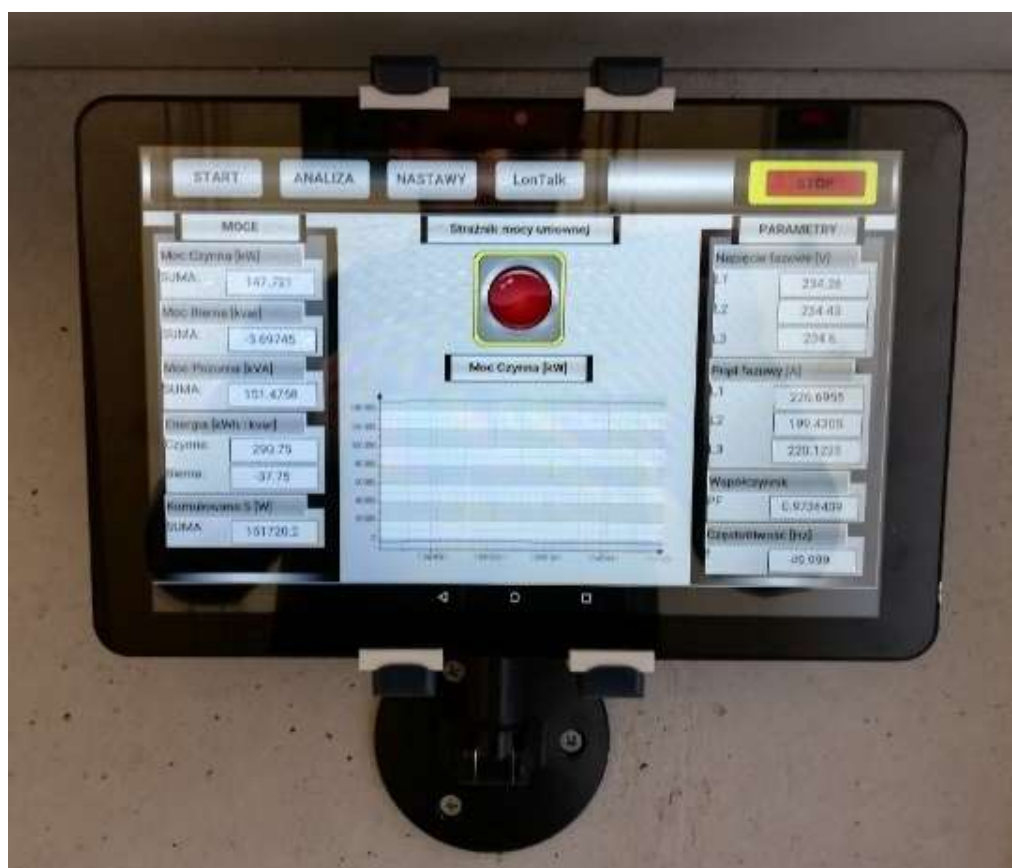
Rys. 5.5 Zdalny panel operatora 57
