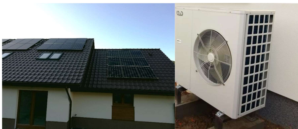
Rys. 5.20 Instalacja prosumenta II 71
