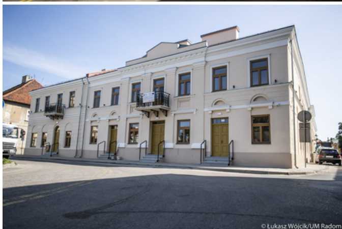
Kamienica Deskurów – wczesny etap remontu i stan obecny
