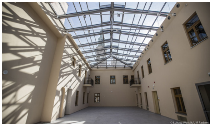
Różne aspekty kompleksowego remontu Kamienicy Deskurów: a) prace rozbiórkowe, b) dach po przebudowie, wraz z agregatami instalacji chłodniczej, c) przeszklone zadaszenie dziedzińca.
