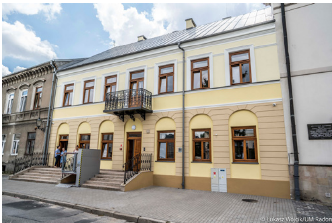
Kamienica przy ul. Rynek 12 po remoncie
