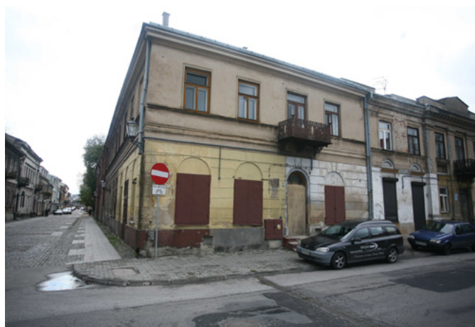
Kamienica Deskurów przed remontem
