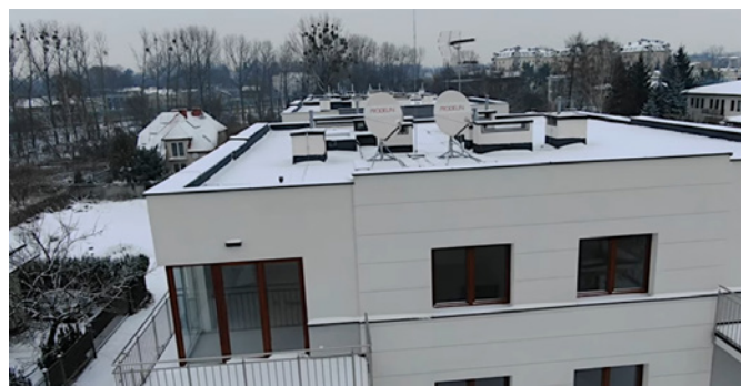
Fot. 3. Pole antenowe na budynku w osiedlu Skłepowa 22 (kliknij, by obejrzeć film!)
