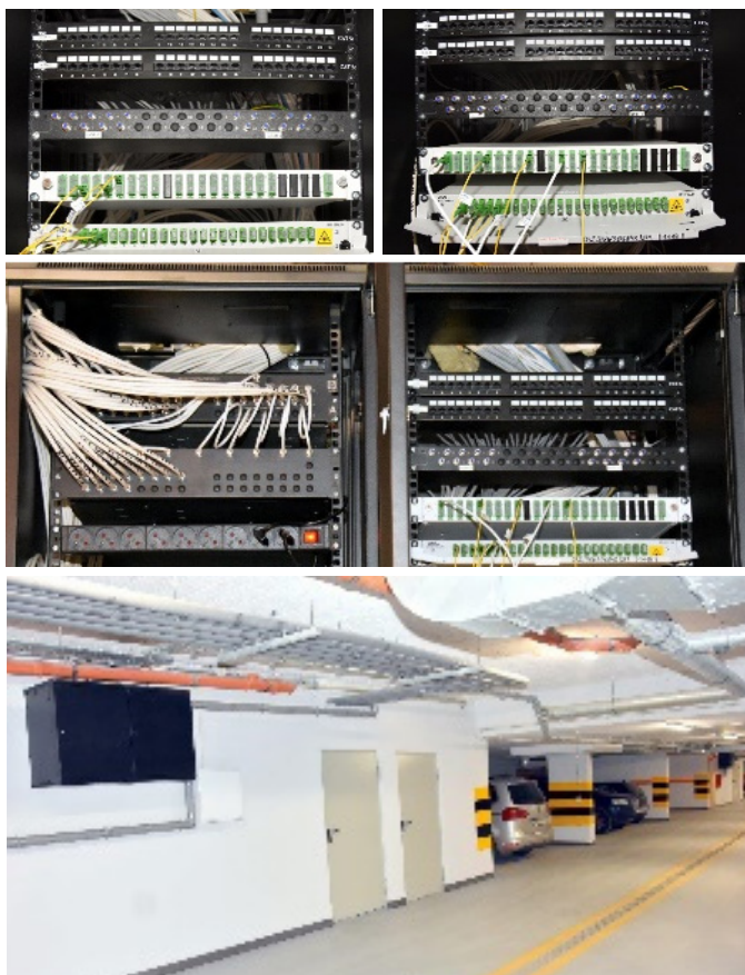
Fot. 2. Punkty styku zainstalowane w garażach na osiedlu Skłepowa 22.
